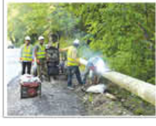
کارگران در حال اجرای شبکه گاز در مناطق روستایی استان خراسان.
